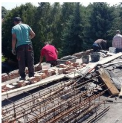
MODERNIZACJA DACHU NA BUDYNKU ZSO w PODOLSZU
