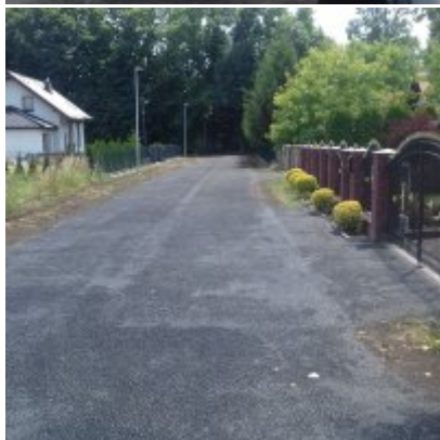
Modernizacja ul. Grunwaldzkiej
