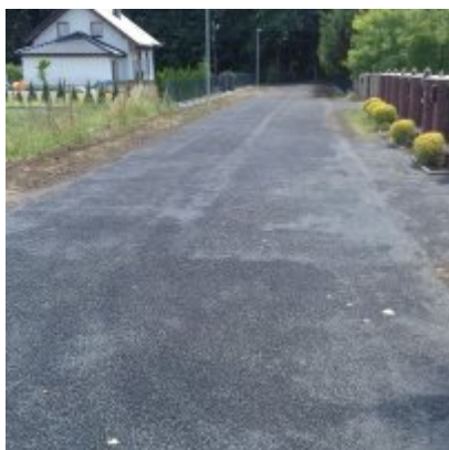
Modernizacja ul. Grunwaldzkiej
