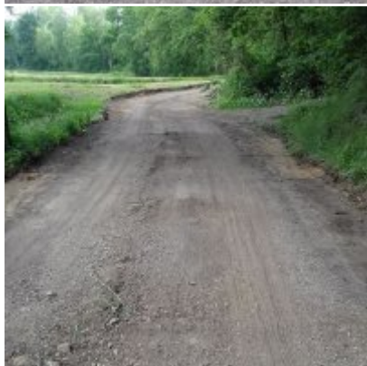
Modernizacja drogi wewnętrznej
