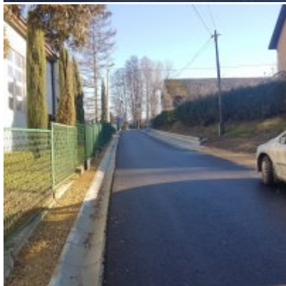
Zakończono przebudowę drogi gminnej – ul. Grabskiego.
