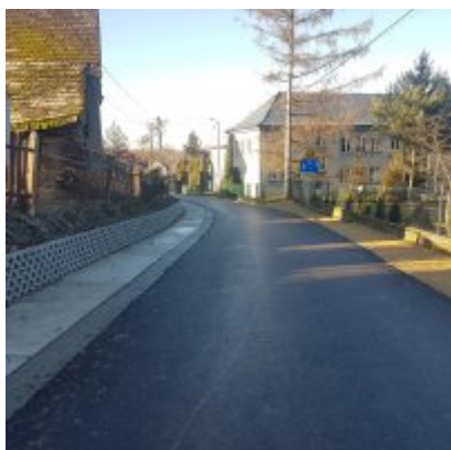
Zakończono przebudowę drogi gminnej – ul. Grabskiego.
