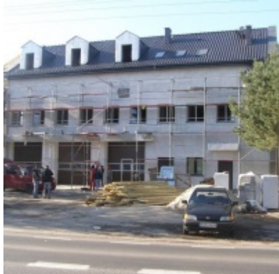
Modernizacja OSP w Zatorze
