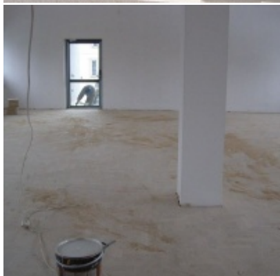
Modernizacja OSP w Zatorze
