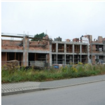
Budowa "Centrum Aktywizacji Zawodowej"
