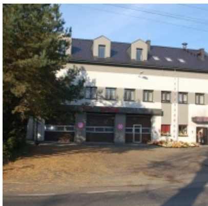
Modernizacja OSP w Zatorze
