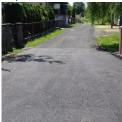
Modernizacja drogi wewnętrznej w Laskowej, na dł. ok. 120 mb, frezem asfaltowym ze skropieniem. Wartość robót 16.605,00 zł.
