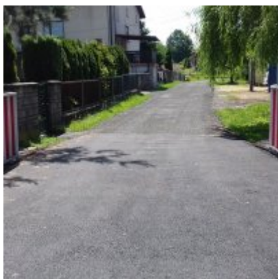
Modernizacja drogi wewnętrznej w Laskowej, na dł. ok. 120 mb, frezem asfaltowym ze skropieniem. Wartość robót 16.605,00 zł.
