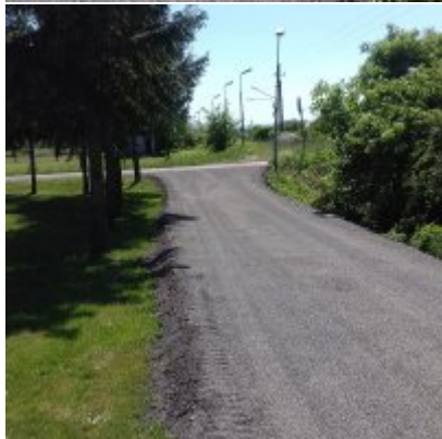
Rozpoczęcie robót remontowych
