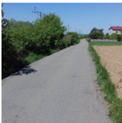
Rozpoczęcie robót remontowych
