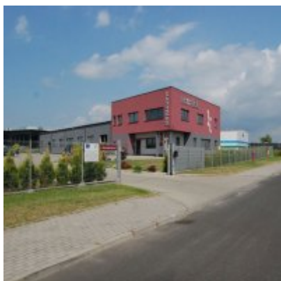
Zatorska Strefa Aktywności Gospodarczej FOTOGALERIA - czerwiec 2017
