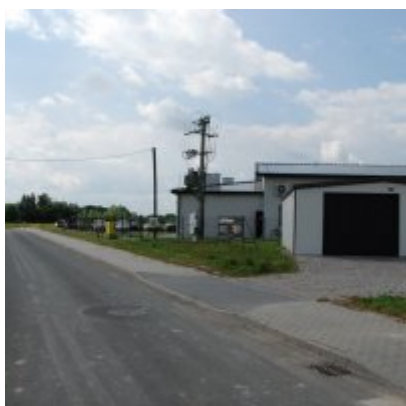
Zatorska Strefa Aktywności Gospodarczej FOTOGALERIA - czerwiec 2017
