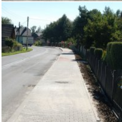
Wyremontowany chodnik w Podolszu
