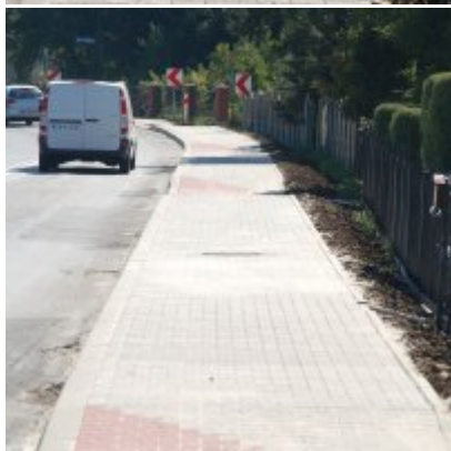
Wyremontowany chodnik w Podolszu
