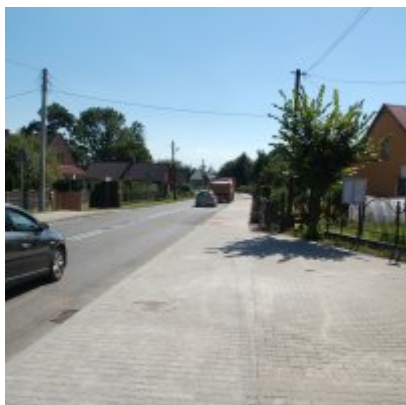
Wyremontowany chodnik w Podolszu
