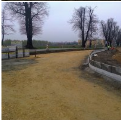
2016-04-13 Bieżący stan prac przy budowie ronda
