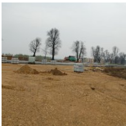
2016-04-13 Bieżący stan prac przy budowie ronda
