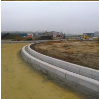
2016-04-13 Bieżący stan prac przy budowie ronda
