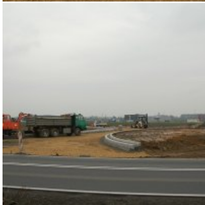
2016-04-13 Bieżący stan prac przy budowie ronda
