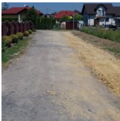
Rozpoczęto prace modernizacyjne na ul. Grunwaldzkiej.
