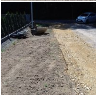
Rozpoczęto prace modernizacyjne na ul. Grunwaldzkiej
