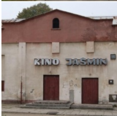
Rozbudowa i remont Regionalnego Ośrodka Kultury
