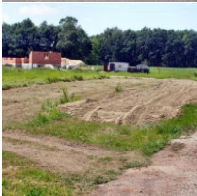
Inwestycje drogowe realizowane w 2009 r. - Brzezina
