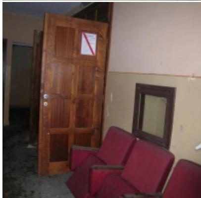
Rozbudowa i remont Regionalnego Ośrodka Kultury
