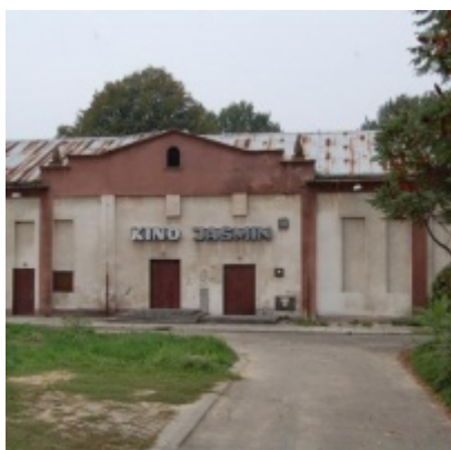
Rozbudowa i remont Regionalnego Ośrodka Kultury
