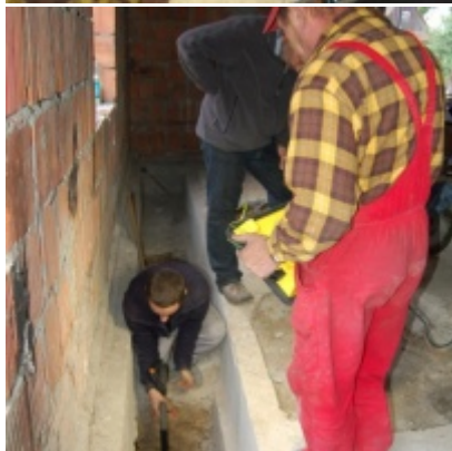
Rozbudowa i remont budynków Urzędu Miejskiego 2008/2010
