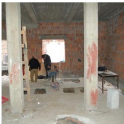
Rozbudowa i remont budynków Urzędu Miejskiego 2008/2010
