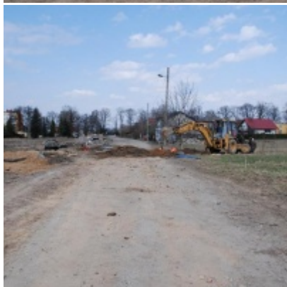
Kompleksowa modernizacja ciągu komunikacyjnego - ul. J. Słowackiego
