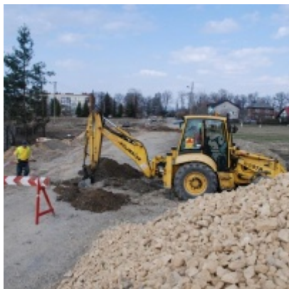
Kompleksowa modernizacja ciągu komunikacyjnego - ul. J. Słowackiego
