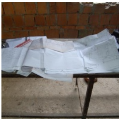
Rozbudowa i remont budynków Urzędu Miejskiego 2008/2010
