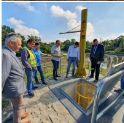
Budowa nowego ujęcia wody z rzeki Skawy.
