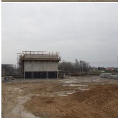
Postęp prac na budowie obwodnicy Podolsza DW 781
