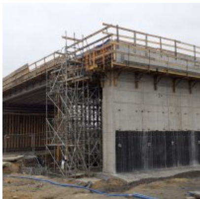
Postęp prac na budowie obwodnicy Podolsza DW 781
