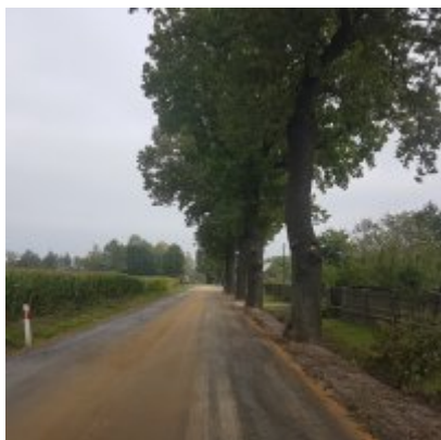
Praca wre - modernizacja drogi wojewódzkiej.
