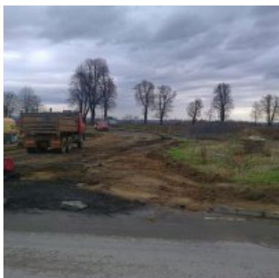
Budowa drogi gminnej od ul. W. Grabskiego do DK 44 (o dł. ok. 60 mb), stanowiącej dojazd do Strefy Aktywności Gospodarczej Małopolski Zachodniej w Zatorze, wraz z jej włączeniem do DK 44 w formie ronda, Koszt robót 1 983 000,00 zł brutto
