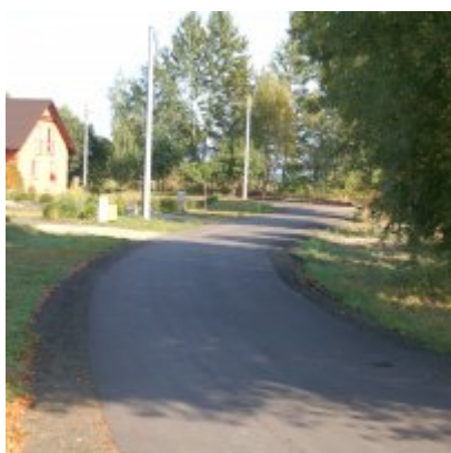
2. Przebudowa ul. Jagodowej w Podolszu
