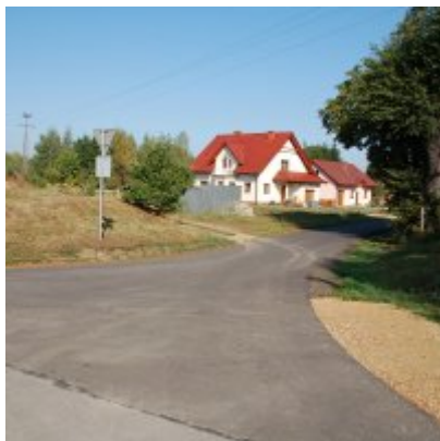
2. Przebudowa ul. Jagodowej w Podolszu
