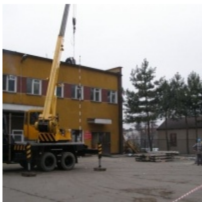
Przebudowa i modernizacja remizy strażackiej w Zatorze
