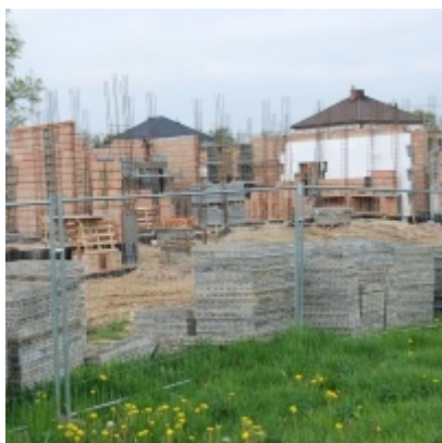
Budowa "Centrum Aktywizacji Zawodowej"
