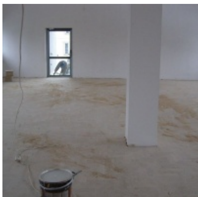
Modernizacja OSP w Zatorze
