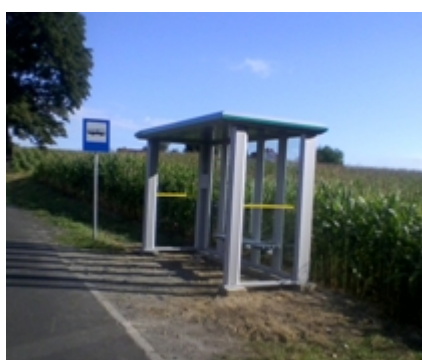
Graboszyce w stronę Zatora nowa wiata
