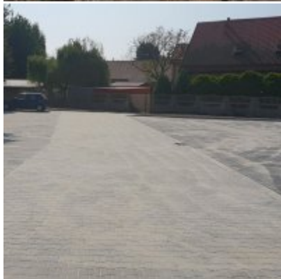
Budowa miejsc postojowych dla samochodów w Zatorze
