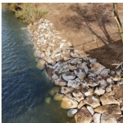
Zabezpieczenie brzegu odcinków Skawy w Gminie Zator
