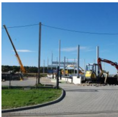
Fotogaleria Zatorskiej Strefy Aktywności Gospodarczej
