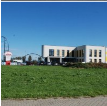
Fotogaleria Zatorskiej Strefy Aktywności Gospodarczej
