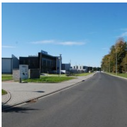
Fotogaleria Zatorskiej Strefy Aktywności Gospodarczej
