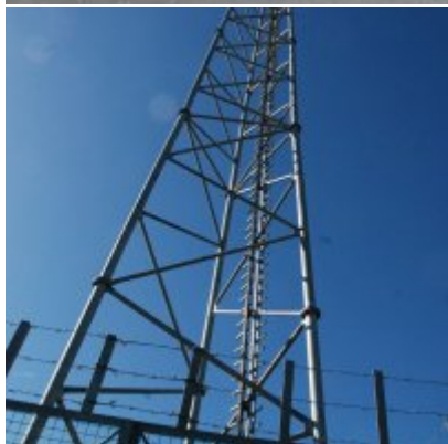
Fotogaleria Zatorskiej Strefy Aktywności Gospodarczej
