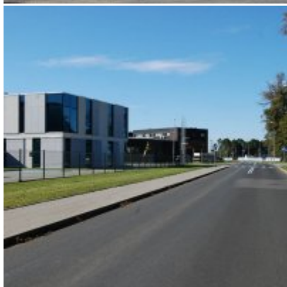
Fotogaleria Zatorskiej Strefy Aktywności Gospodarczej
