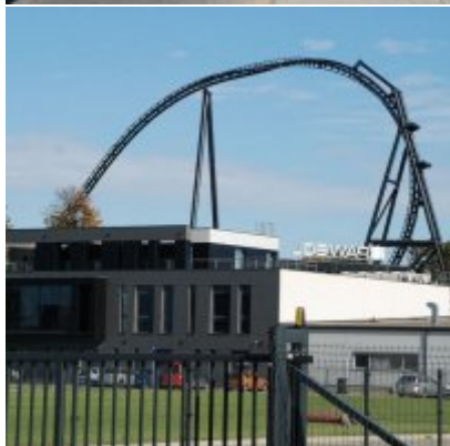
Fotogaleria Zatorskiej Strefy Aktywności Gospodarczej
