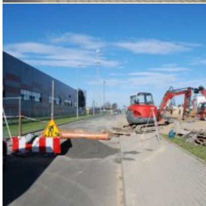
Fotogaleria Zatorskiej Strefy Aktywności Gospodarczej
