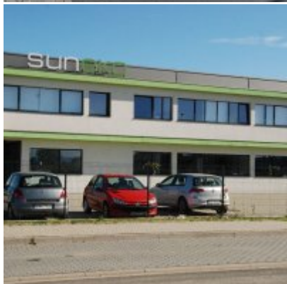
Fotogaleria Zatorskiej Strefy Aktywności Gospodarczej
