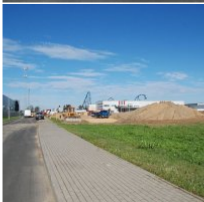
Fotogaleria Zatorskiej Strefy Aktywności Gospodarczej
