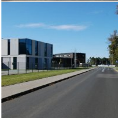
Fotogaleria Zatorskiej Strefy Aktywności Gospodarczej
