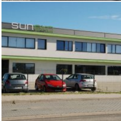
Fotogaleria Zatorskiej Strefy Aktywności Gospodarczej
