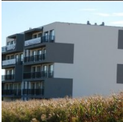
Fotogaleria Zatorskiej Strefy Aktywności Gospodarczej
