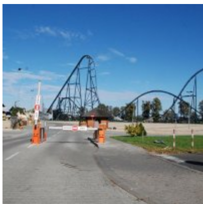
Fotogaleria Zatorskiej Strefy Aktywności Gospodarczej
