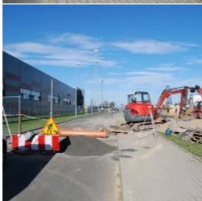
Fotogaleria Zatorskiej Strefy Aktywności Gospodarczej
