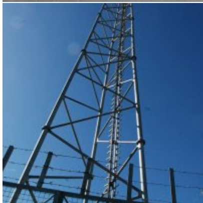
Fotogaleria Zatorskiej Strefy Aktywności Gospodarczej
