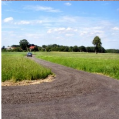
Inwestycje drogowe realizowane w 2009 r. - Graboszyce
