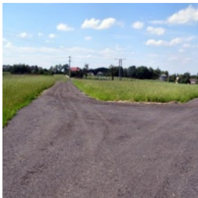
Inwestycje drogowe realizowane w 2009 r. - Graboszyce
