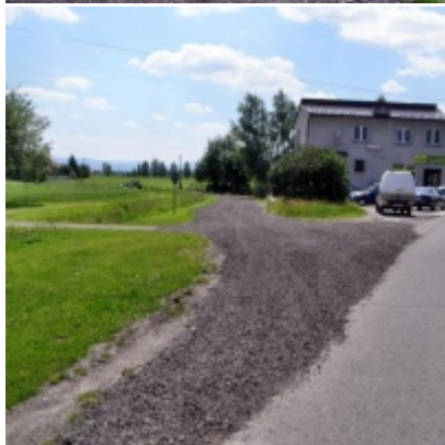
Inwestycje drogowe realizowane w 2009 r. - Stawowa
