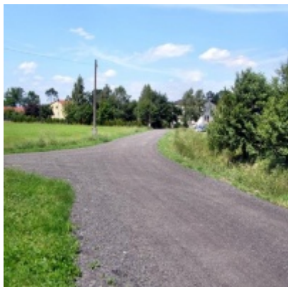
Inwestycje drogowe realizowane w 2009 r. - Stawowa
