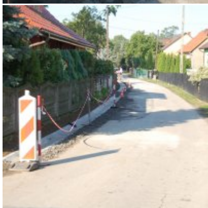
Budowa odwodnienia ul. Gimnazjalnej w Podolszu
