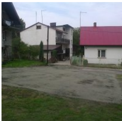
II etap modernizacji ul. Młyńskiej w Zatorze
