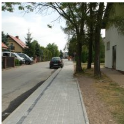
CHODNIK-UL. PALIMĄKI ZATOR
