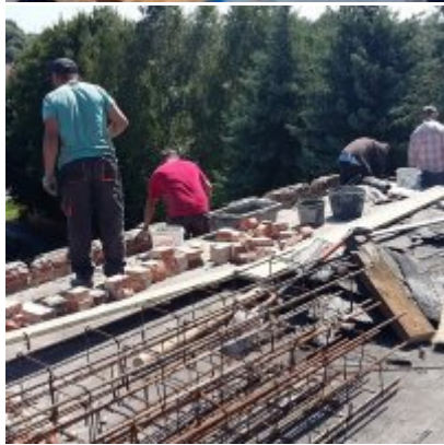
MODERNIZACJA DACHU NA BUDYNKU ZSO w PODOLSZU
