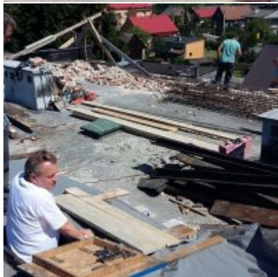
MODERNIZACJA DACHU NA BUDYNKU ZSO w PODOLSZU
