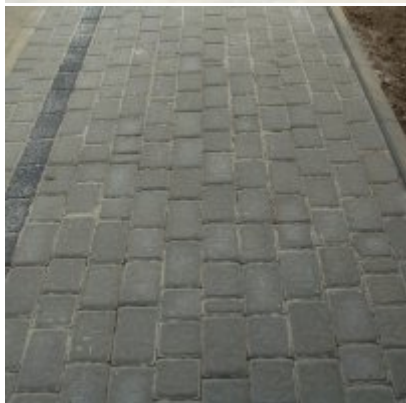
CHODNIK-UL. PALIMĄKI ZATOR
