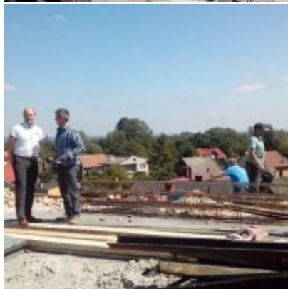
MODERNIZACJA DACHU NA BUDYNKU ZSO w PODOLSZU
