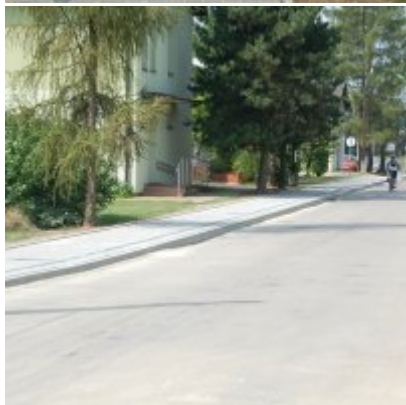
CHODNIK-UL. PALIMĄKI ZATOR
