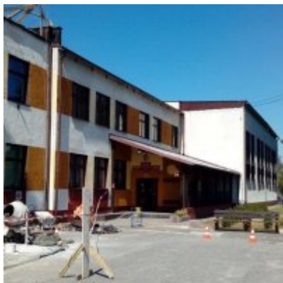
MODERNIZACJA DACHU NA BUDYNKU ZSO w PODOLSZU
