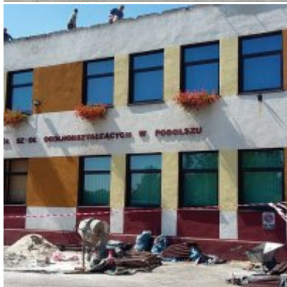
MODERNIZACJA DACHU NA BUDYNKU ZSO w PODOLSZU
