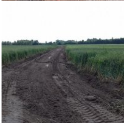
Modernizacja drogi wewnętrznej
