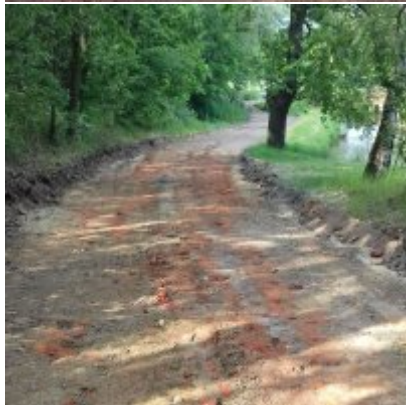
Modernizacja drogi wewnętrznej
