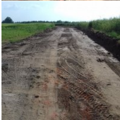
Modernizacja drogi wewnętrznej
