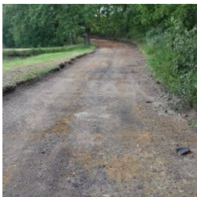
Modernizacja drogi wewnętrznej
