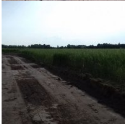
Modernizacja drogi wewnętrznej
