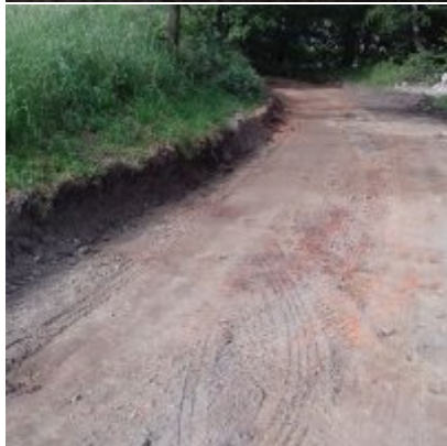
Modernizacja drogi wewnętrznej
