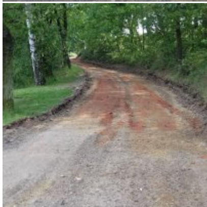
Modernizacja drogi wewnętrznej
