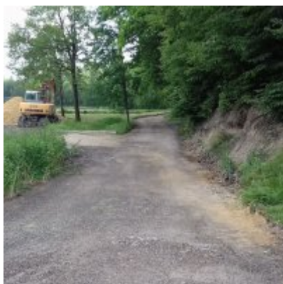
Modernizacja drogi wewnętrznej
