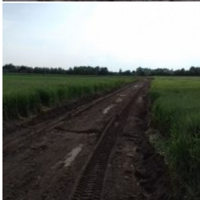
Modernizacja drogi wewnętrznej
