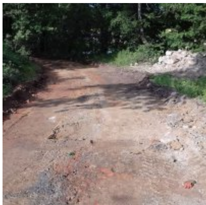
Modernizacja drogi wewnętrznej
