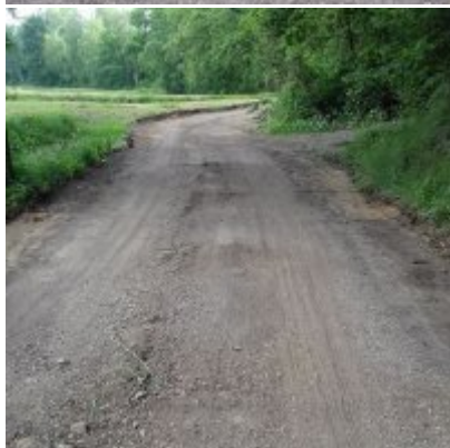
Modernizacja drogi wewnętrznej
