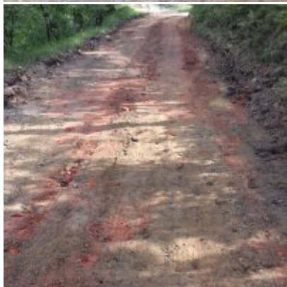
Modernizacja drogi wewnętrznej
