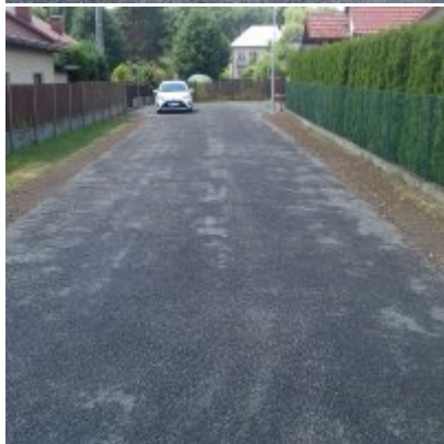
Modernizacja ul. Grunwaldzkiej
