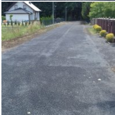
Modernizacja ul. Grunwaldzkiej
