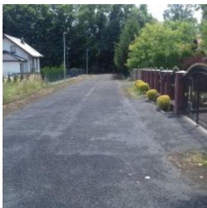
Modernizacja ul. Grunwaldzkiej
