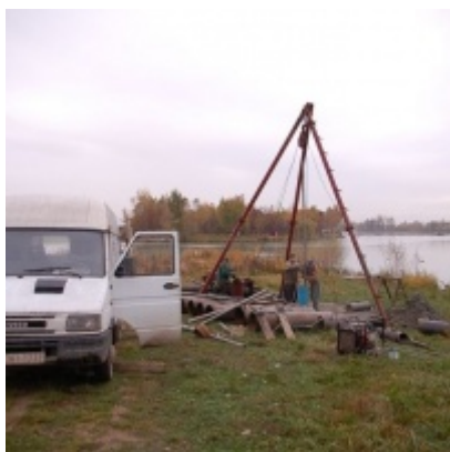
Nowe ujęcie wody pitnej
