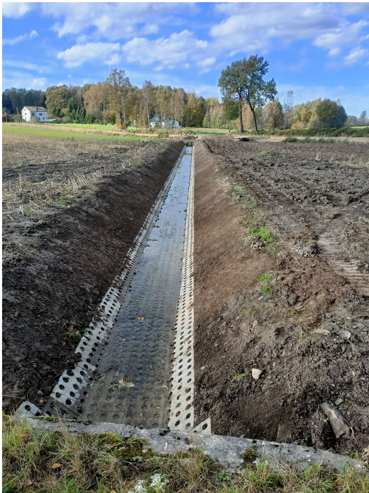
Odbudowa rowu Łowiczanka stanowi ważny krok w kierunku ochrony terenów rolniczych. Inwestycja ta wpisuje się w zrównoważony rozwój gminy, chroniąc grunty rolne, zapewnia stabilność środowiska naturalnego.
