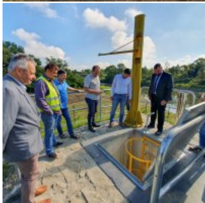
Budowa nowego ujęcia wody z rzeki Skawy.
