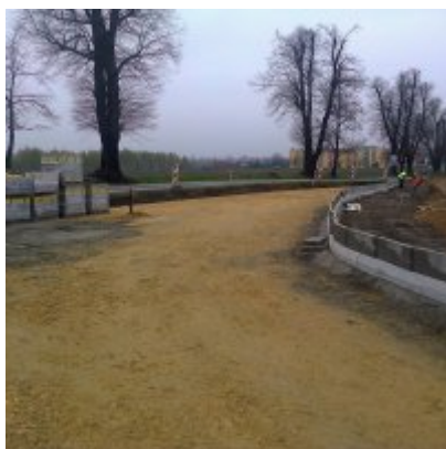
2016-04-13 Bieżący stan prac przy budowie ronda
