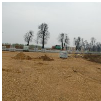
2016-04-13 Bieżący stan prac przy budowie ronda
