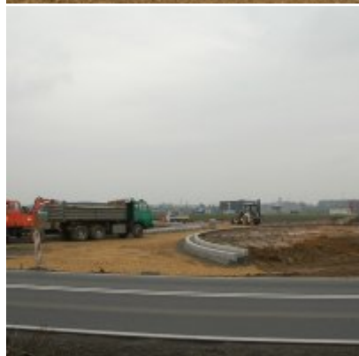
2016-04-13 Bieżący stan prac przy budowie ronda
