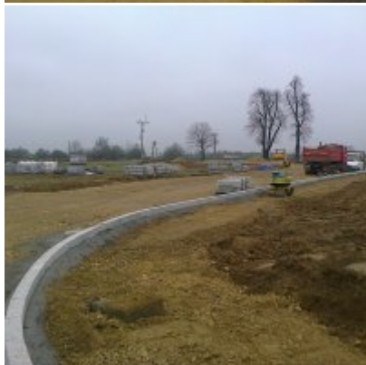
2016-04-13 Bieżący stan prac przy budowie ronda
