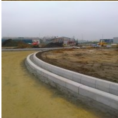
2016-04-13 Bieżący stan prac przy budowie ronda
