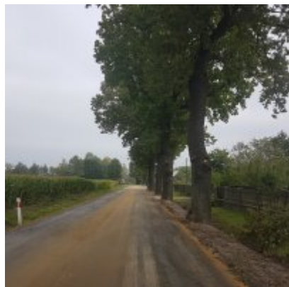
Praca wre – modernizacja drogi wojewódzkiej.
