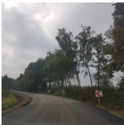
Praca wre - modernizacja drogi wojewódzkiej.
