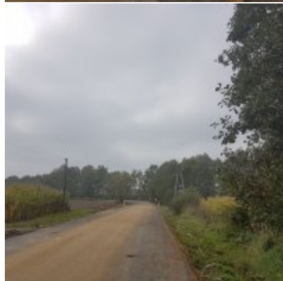
Praca wre – modernizacja drogi wojewódzkiej.
