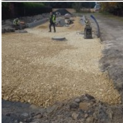
Prace budowlane na Al. Chopina w Zatorze
