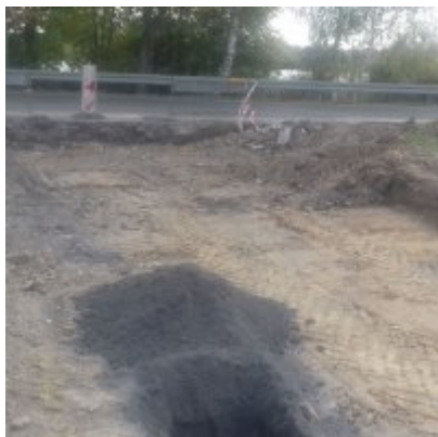
Prace budowlane na Al. Chopina w Zatorze
