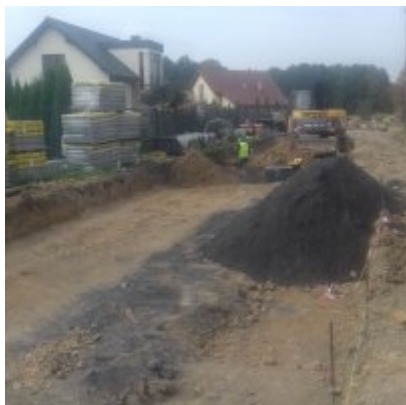
Prace budowlane na Al. Chopina w Zatorze
