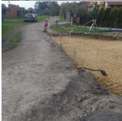
Prace budowlane na Al. Chopina w Zatorze
