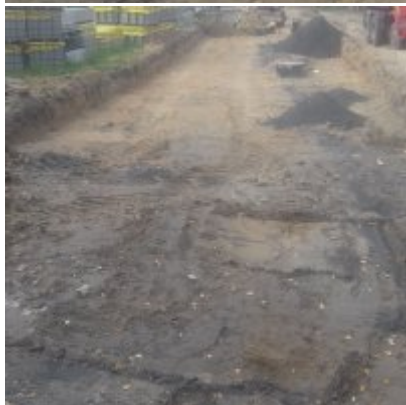
Prace budowlane na Al. Chopina w Zatorze
