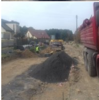
Prace budowlane na Al. Chopina w Zatorze
