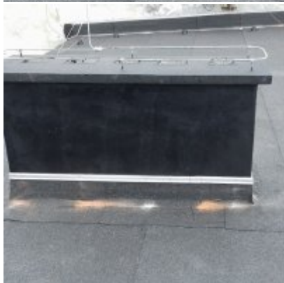
Remont dachu Szkoły podstawowej w Laskowej
