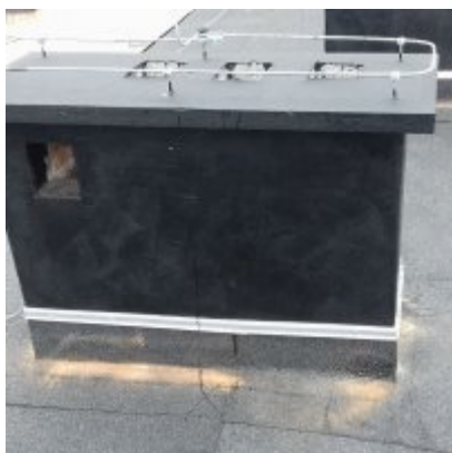
Remont dachu Szkoły podstawowej w Laskowej
