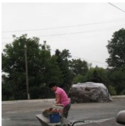
Remont dachu w ZSO Podolsze
