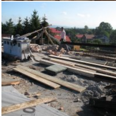
Remont dachu w ZSO Podolsze
