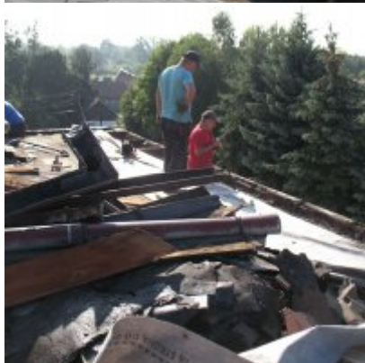
Remont dachu w ZSO Podolsze
