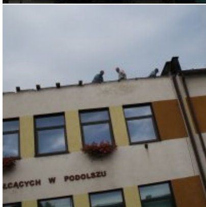
Remont dachu w ZSO Podolsze
