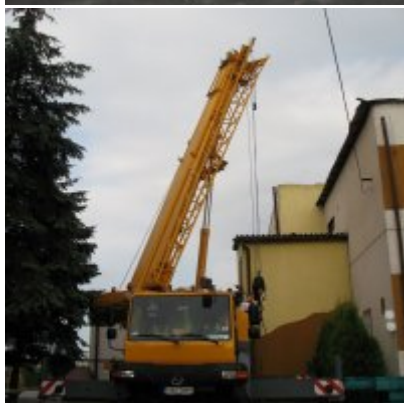
Remont dachu w ZSO Podolsze
