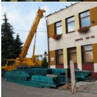
Remont dachu w ZSO Podolsze
