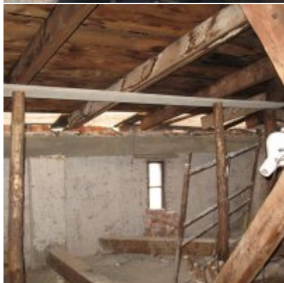
Remont dachu w ZSO Podolsze
