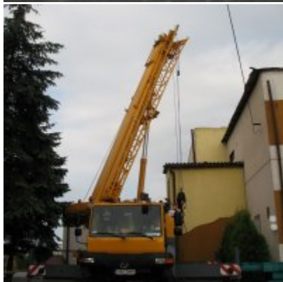
Remont dachu w ZSO Podolsze
