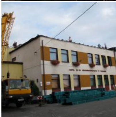
Remont dachu w ZSO Podolsze
