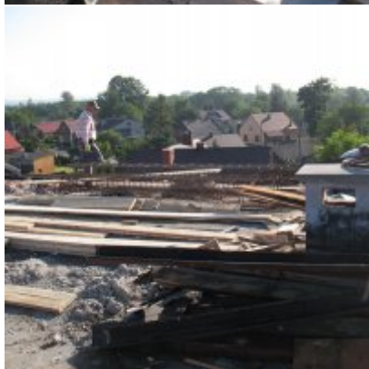
Remont dachu w ZSO Podolsze
