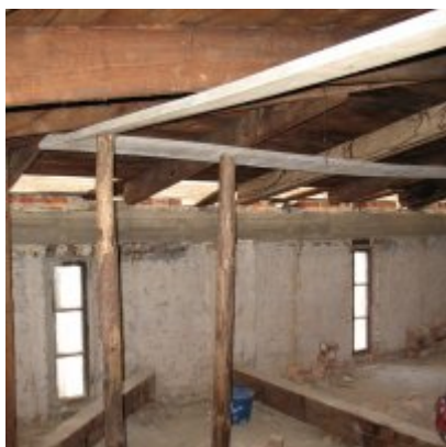
Remont dachu w ZSO Podolsze
