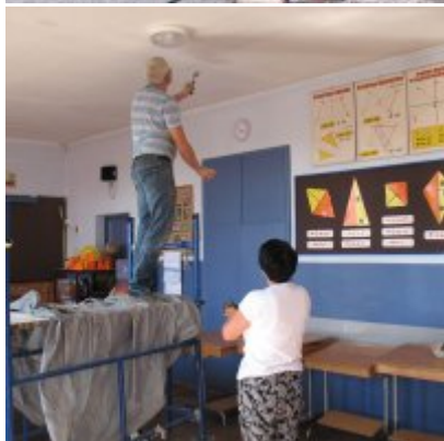
Remont dachu w ZSO Podolsze
