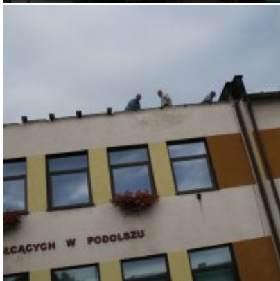
Remont dachu w ZSO Podolsze
