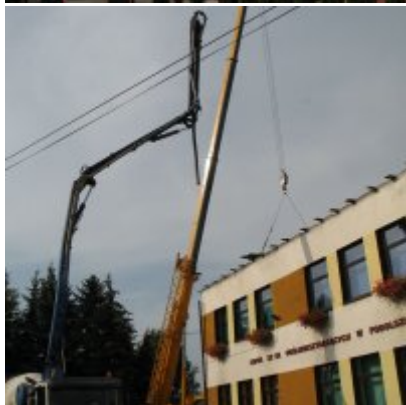
Remont dachu w ZSO Podolsze
