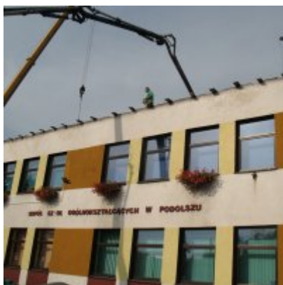
Remont dachu w ZSO Podolsze
