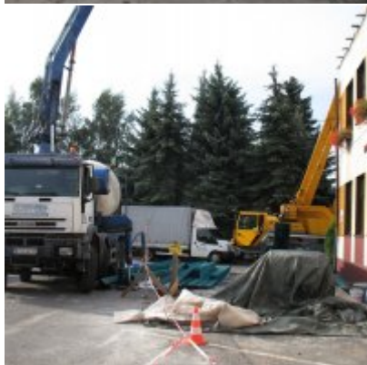
Remont dachu w ZSO Podolsze
