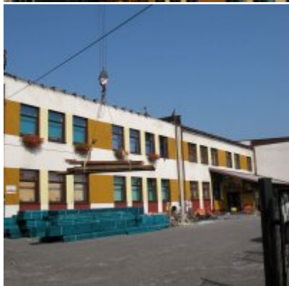
Remont dachu w ZSO Podolsze
