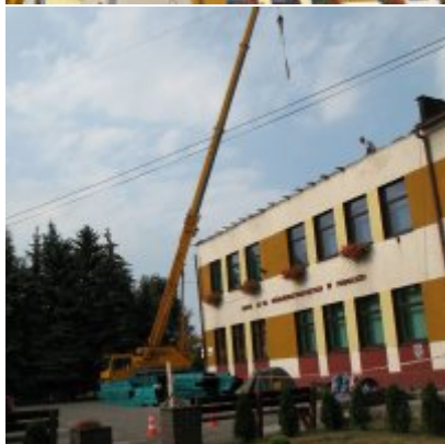
Remont dachu w ZSO Podolsze
