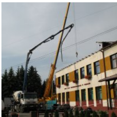
Remont dachu w ZSO Podolsze
