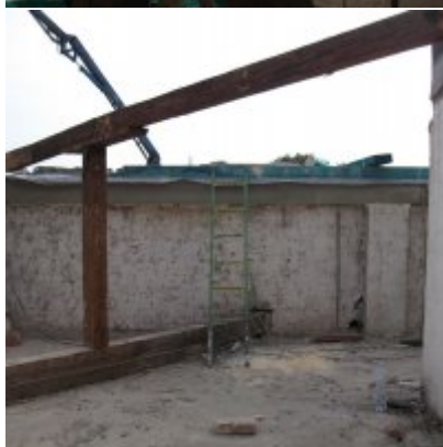
Remont dachu w ZSO Podolsze
