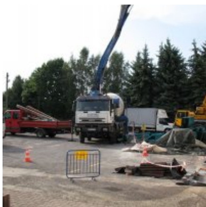
Remont dachu w ZSO Podolsze
