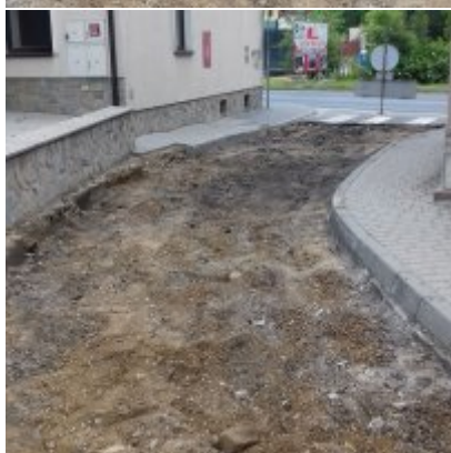
Remont ulicy Szkolnej w Zatorze
