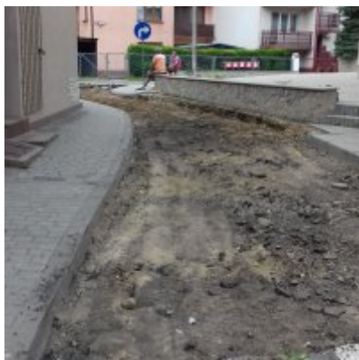
Remont ulicy Szkolnej w Zatorze
