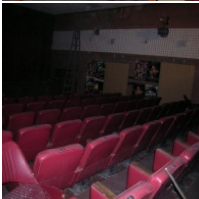
Rozbudowa i remont Regionalnego Ośrodka Kultury
