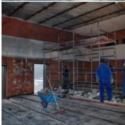
Rozbudowa i remont Regionalnego Ośrodka Kultury
