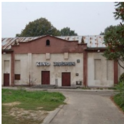
Rozbudowa i remont Regionalnego Ośrodka Kultury
