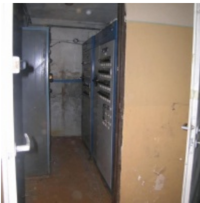
Rozbudowa i remont Regionalnego Ośrodka Kultury
