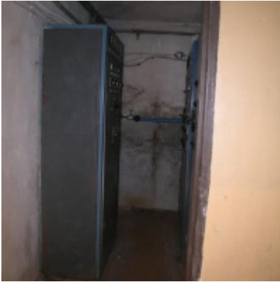
Rozbudowa i remont Regionalnego Ośrodka Kultury
