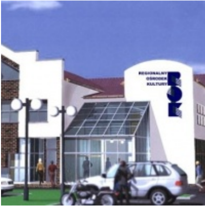
Rozbudowa i remont Regionalnego Ośrodka Kultury
