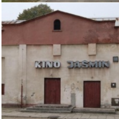
Rozbudowa i remont Regionalnego Ośrodka Kultury
