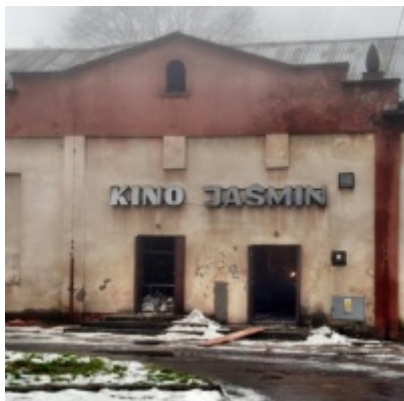
Rozbudowa i remont Regionalnego Ośrodka Kultury
