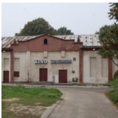
Rozbudowa i remont Regionalnego Ośrodka Kultury
