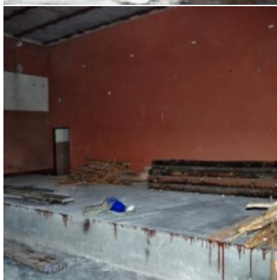
Rozbudowa i remont Regionalnego Ośrodka Kultury
