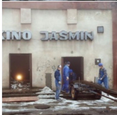
Rozbudowa i remont Regionalnego Ośrodka Kultury
