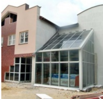
Rozbudowa i remont Regionalnego Ośrodka Kultury
