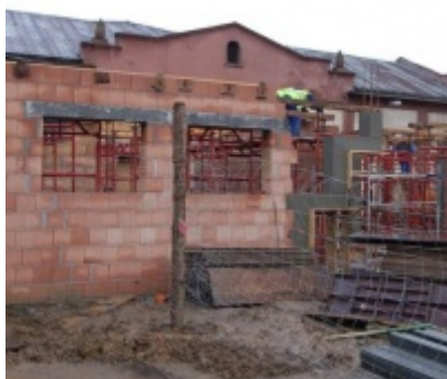
Rozbudowa i remont Regionalnego Ośrodka Kultury
