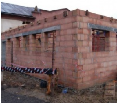
Rozbudowa i remont Regionalnego Ośrodka Kultury
