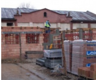
Rozbudowa i remont Regionalnego Ośrodka Kultury
