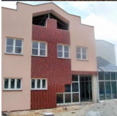
Rozbudowa i remont Regionalnego Ośrodka Kultury
