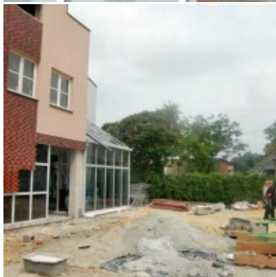
Rozbudowa i remont Regionalnego Ośrodka Kultury
