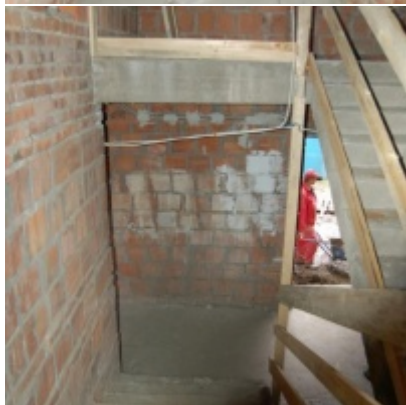
Rozbudowa i remont budynków Urzędu Miejskiego 2008/2010
