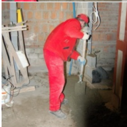
Rozbudowa i remont budynków Urzędu Miejskiego 2008/2010
