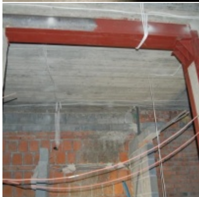
Rozbudowa i remont budynków Urzędu Miejskiego 2008/2010
