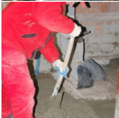
Rozbudowa i remont budynków Urzędu Miejskiego 2008/2010
