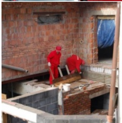
Rozbudowa i remont budynków Urzędu Miejskiego 2008/2010
