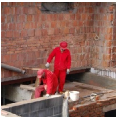
Rozbudowa i remont budynków Urzędu Miejskiego 2008/2010
