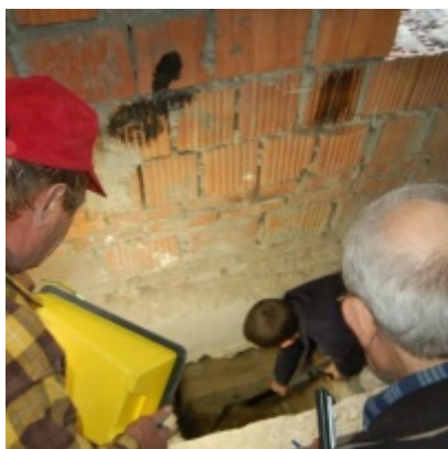
Rozbudowa i remont budynków Urzędu Miejskiego 2008/2010
