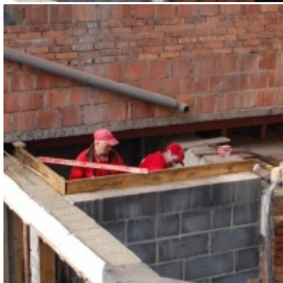
Rozbudowa i remont budynków Urzędu Miejskiego 2008/2010
