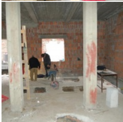
Rozbudowa i remont budynków Urzędu Miejskiego 2008/2010
