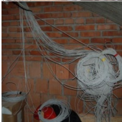
Rozbudowa i remont budynków Urzędu Miejskiego 2008/2010
