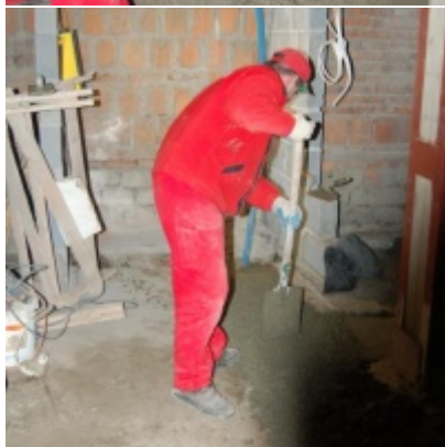
Rozbudowa i remont budynków Urzędu Miejskiego 2008/2010
