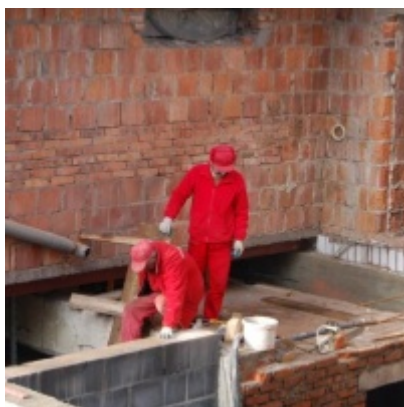
Rozbudowa i remont budynków Urzędu Miejskiego 2008/2010
