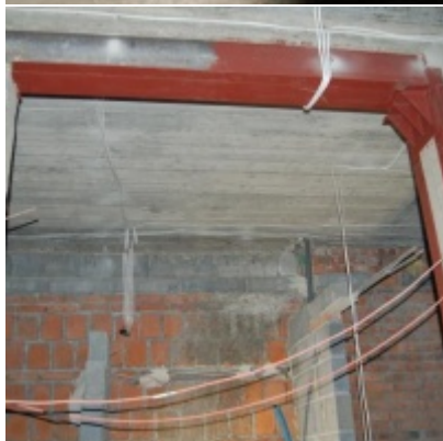
Rozbudowa i remont budynków Urzędu Miejskiego 2008/2010
