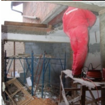
Rozbudowa i remont budynków Urzędu Miejskiego 2008/2010
