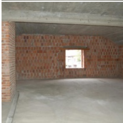
Rozbudowa i remont budynków Urzędu Miejskiego 2008/2010
