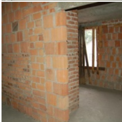
Rozbudowa i remont budynków Urzędu Miejskiego 2008/2010
