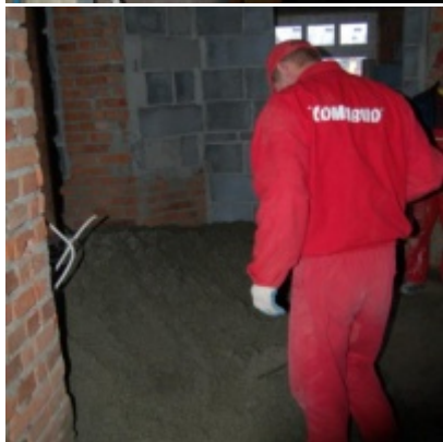
Rozbudowa i remont budynków Urzędu Miejskiego 2008/2010
