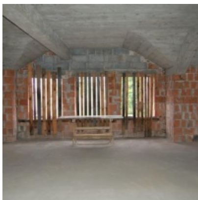
Rozbudowa i remont budynków Urzędu Miejskiego 2008/2010
