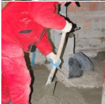
Rozbudowa i remont budynków Urzędu Miejskiego 2008/2010
