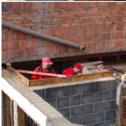
Rozbudowa i remont budynków Urzędu Miejskiego 2008/2010
