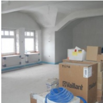
Rozbudowa i remont budynków Urzędu Miejskiego 2008/2010
