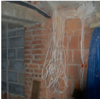
Rozbudowa i remont budynków Urzędu Miejskiego 2008/2010
