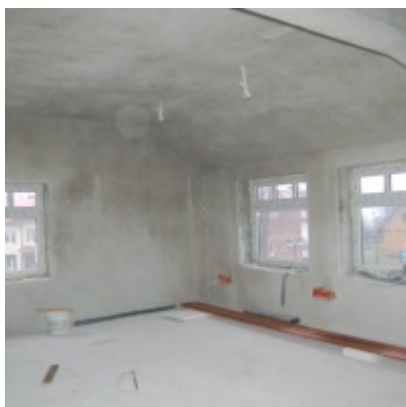
Rozbudowa i remont budynków Urzędu Miejskiego 2008/2010
