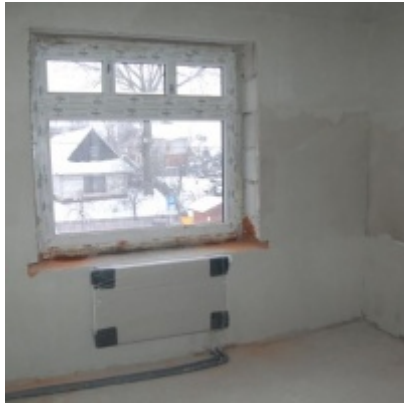
Rozbudowa i remont budynków Urzędu Miejskiego 2008/2010
