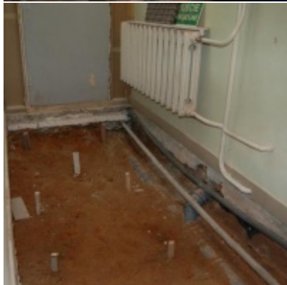
Rozbudowa i remont budynków Urzędu Miejskiego 2008/2010
