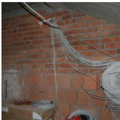
Rozbudowa i remont budynków Urzędu Miejskiego 2008/2010
