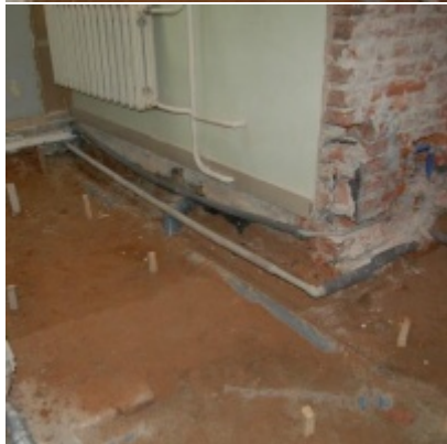
Rozbudowa i remont budynków Urzędu Miejskiego 2008/2010
