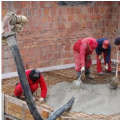
Rozbudowa i remont budynków Urzędu Miejskiego 2008/2010
