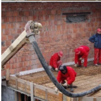
Rozbudowa i remont budynków Urzędu Miejskiego 2008/2010
