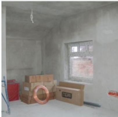
Rozbudowa i remont budynków Urzędu Miejskiego 2008/2010
