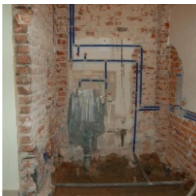
Rozbudowa i remont budynków Urzędu Miejskiego 2008/2010
