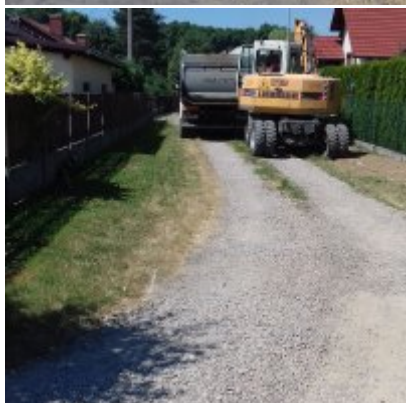
Rozpoczęto prace modernizacyjne na ul. Grunwaldzkiej
