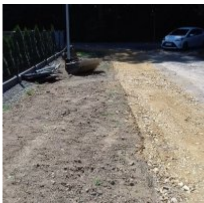
Rozpoczęto prace modernizacyjne na ul. Grunwaldzkiej
