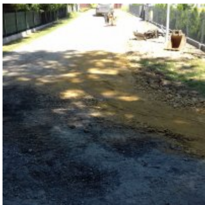
Rozpoczęto prace modernizacyjne na ul. Grunwaldzkiej
