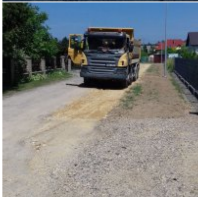
Rozpoczęto prace modernizacyjne na ul. Grunwaldzkiej
